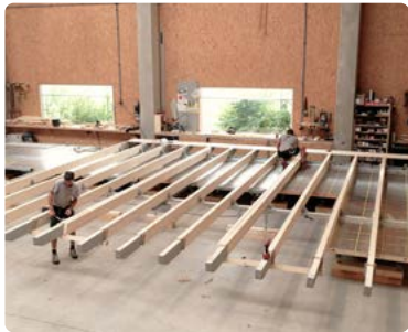
Ganzes Dach auslegen Tisch verbreitern und wie am Bau montieren
