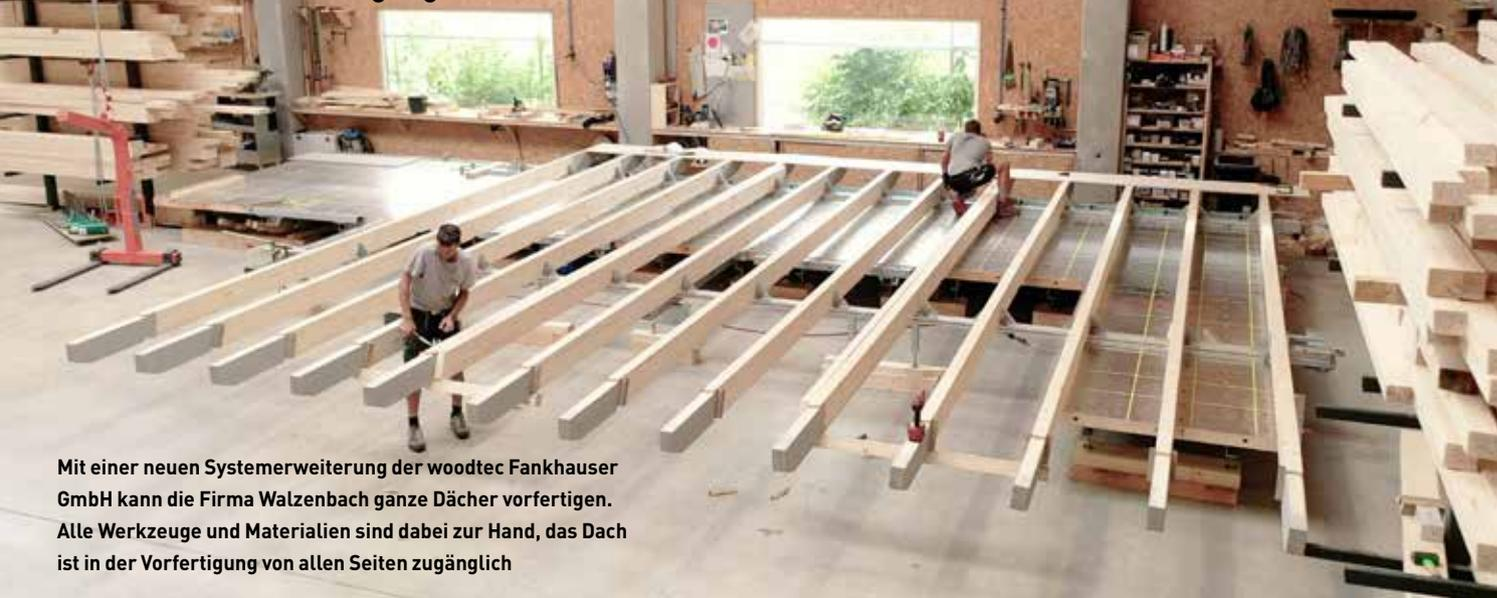
Mit einer neuen Systemerweiterung der woodtec Fankhauser GmbH kann die Firma Walzenbach ganze Dächer vorfertigen. Alle Werkzeuge und Materialien sind dabei zur Hand, das Dach ist in der Vorfertigung von allen Seiten zugänglich
