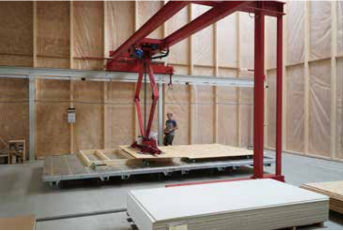
Der Handlingkran mit Vakuumheber entlastet die Mitarbeiter beim Heben von schweren Platten und ermöglicht einem Monteur, sein Element allein zu fertigen
