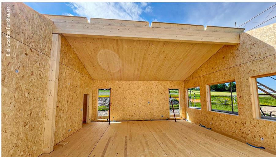
Bei Kastenelementen können bei gleichen statischen Eigenschaften und vergleichbarer Einbauhöhe bis zu 60 Prozent der ansonsten verwendeten Holzmenge eingespart werden. Die Hohlräume können als Installationsebene genutzt werden, für Dämmung oder bei Zwischendecken mit einer Splittschüttung beschwert werden.
