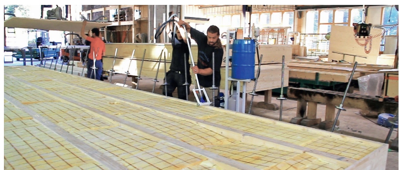
Ein Handklebstoffauftrag ermöglicht ein zuverlässiges und sauberes Auftragen des Klebstoffes. Für die Verwendung mit der Pressvorrichtung ist am Ende ein spezielles Laufrad für den geradlinigen Auftrag angebracht.
