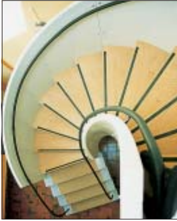
Wandwange aus MDF-Platten 5mm. Senkellänge des Rohlings ca. 1.3 m.
