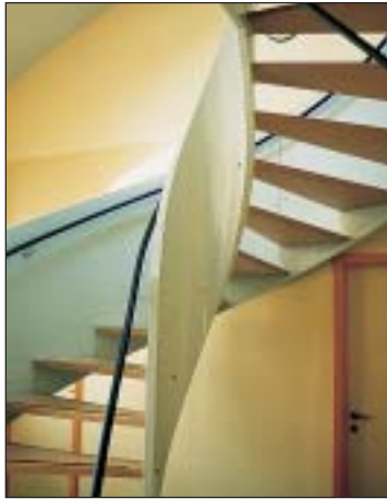
Wandwange aus MDF-Platten 5mm. Senkellänge des Rohlings ca. 1.3 m.
